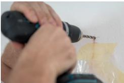
Löcher im Durchmesser 8mm mit einer Mindestdiefe von 100mm in die Wand bohren.
