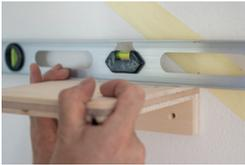
Zu befestigendes Produkt an gewünschte Stelle halten, mit Wasserwaage ausrichten und durch die Löcher mit einem Stift Bohrmakierungen an die Wand zeichnen.
