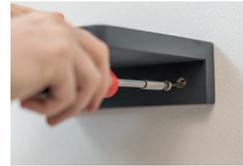
Schrauben eindrehen bis diese fest sind und das Produkt an der Wand hält.
