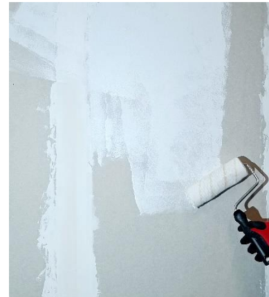
Primaire d'accrochage au rouleau ou patte de lapin Sur support lisse
