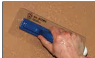
Étape 3 - à mi-séchage, resserer l'enduit à l'aide d'une spatule plastique souple.
