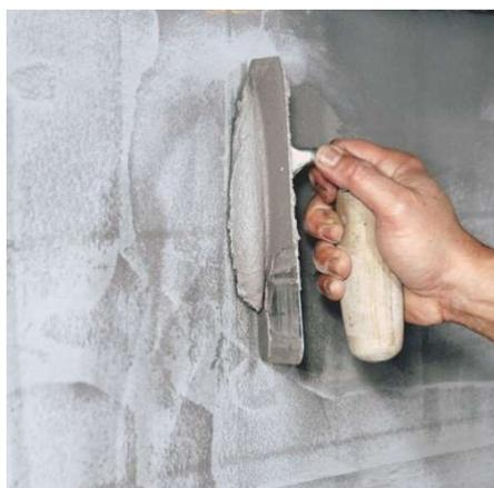
Résine d'adhérence et d'étanchéité polyvalente diluable à l'eau, qui renforce l'accrochage des bétons et mortiers sur tous les supports, même les plus lisses.
