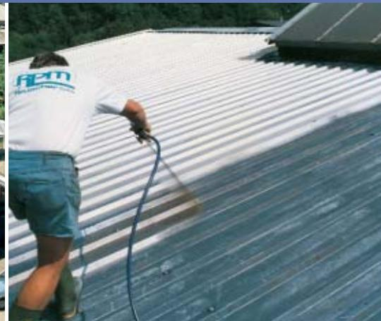
*Alumanation® 301 est un revêtement “hautes performances” pour la protection anticorrosion et l’étanchéité des structures métalliques telles que toitures, bardages de façades, réservoirs de stockage, ponts, charpentes, grues, tuyauteries, antennes et pylones électriques, etc...*
