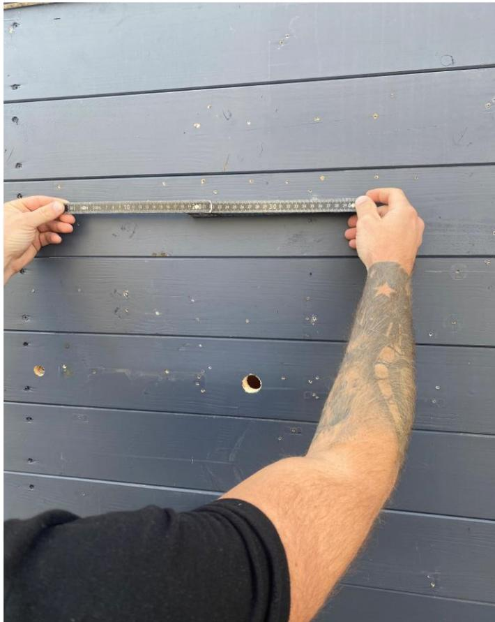
**!! Bei Beton oder Steinmontage 5mm Löcher bohren und Dübel aus dem Lieferumfang in die Bohrlöcher stecken !!**
