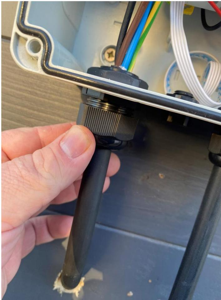
Zuleitungskabel durch die Verschraubung M25 in die Wallbox einführen!
