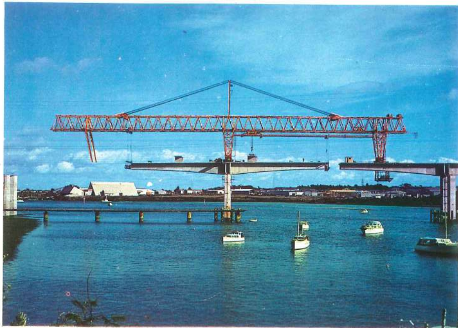
La trave di varo in posizione di lavoro sta disponendo l'ultimo concio di chiusura di una campata Launching-girder in operation positioning the last unit to close a span
