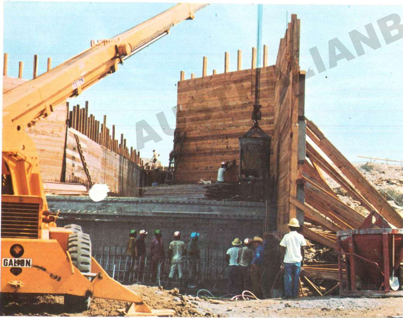
Canale di scarico: getto dello sbocco
