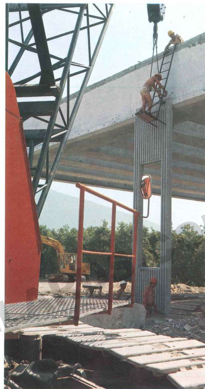
Montaggio di pannello finestra Window panel assembly
