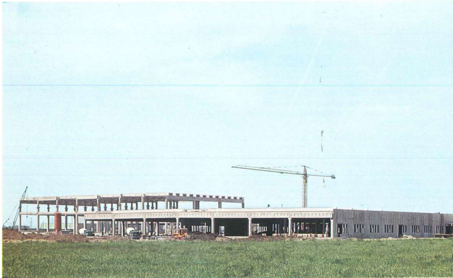
Struttura portante del reparto rotativo
