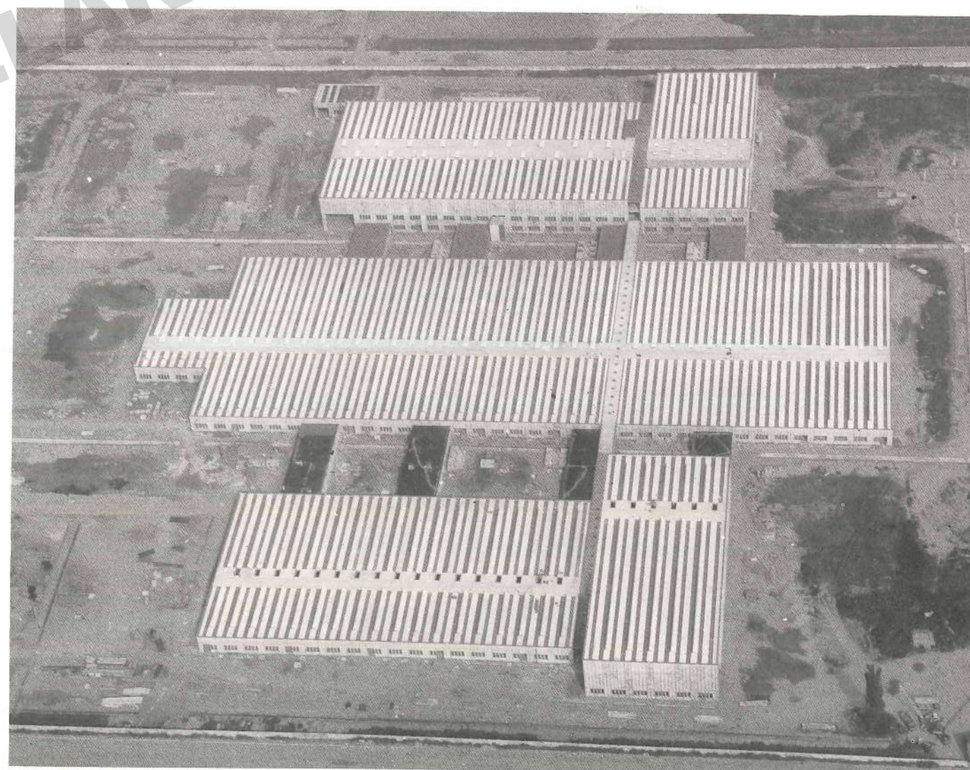
Veduta aerea del fabbricato in fase di finitura
