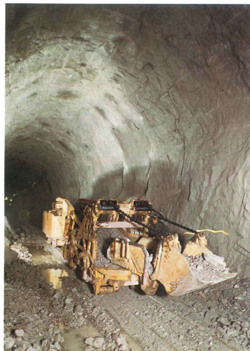
Scavo della finestra di accesso col metodo convenzionale Excavation of the access tunnel using conventional method
