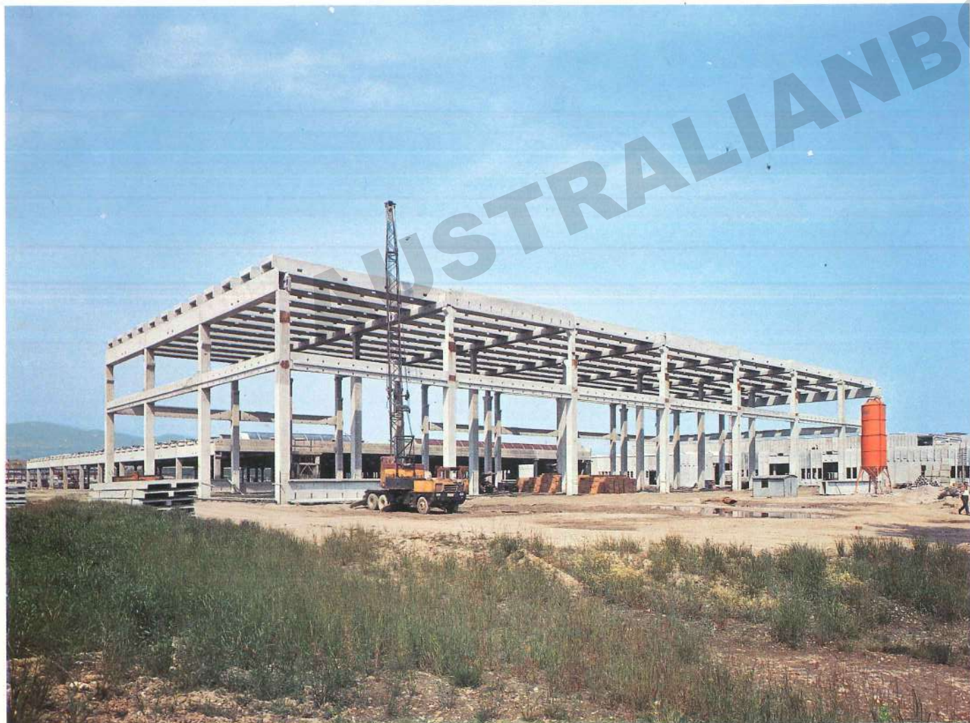
Struttura portante del reparto rotativo
