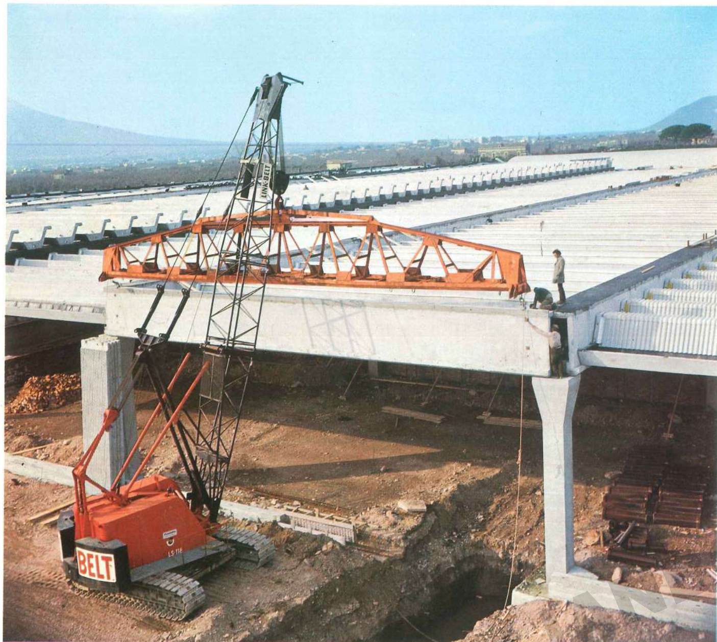
Fase di montaggio delle travi di testata
