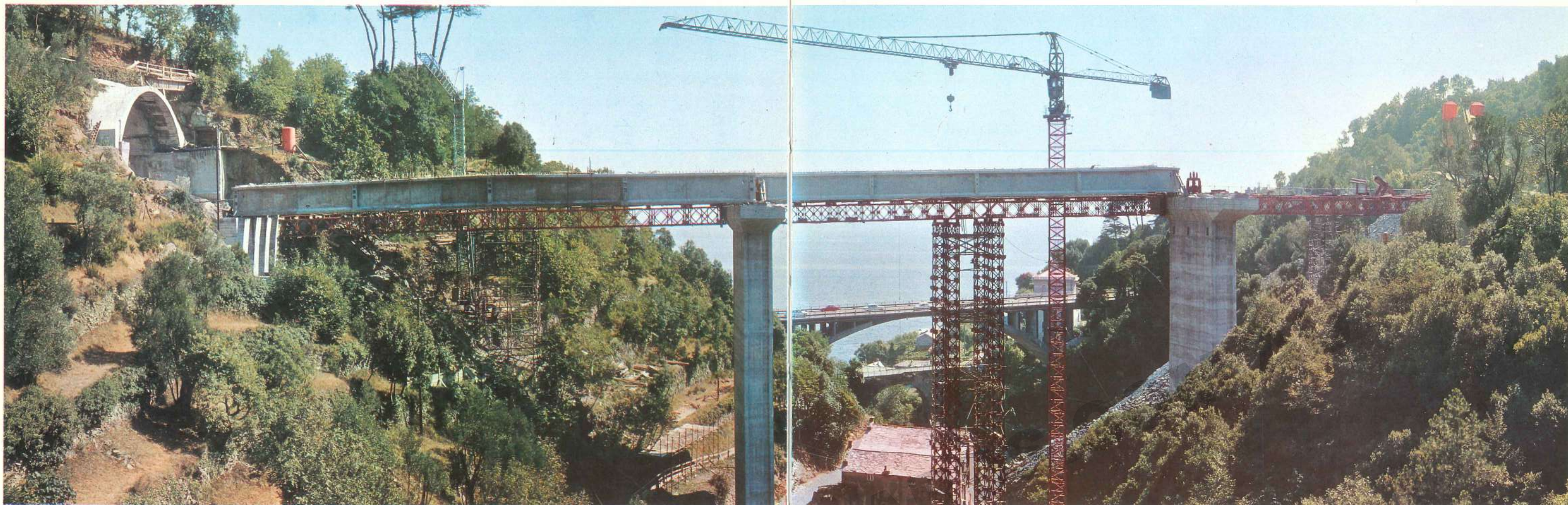
Il getto delle travi è stato realizzato in sito, predisponendo i casseri sulle rispettive campate.
