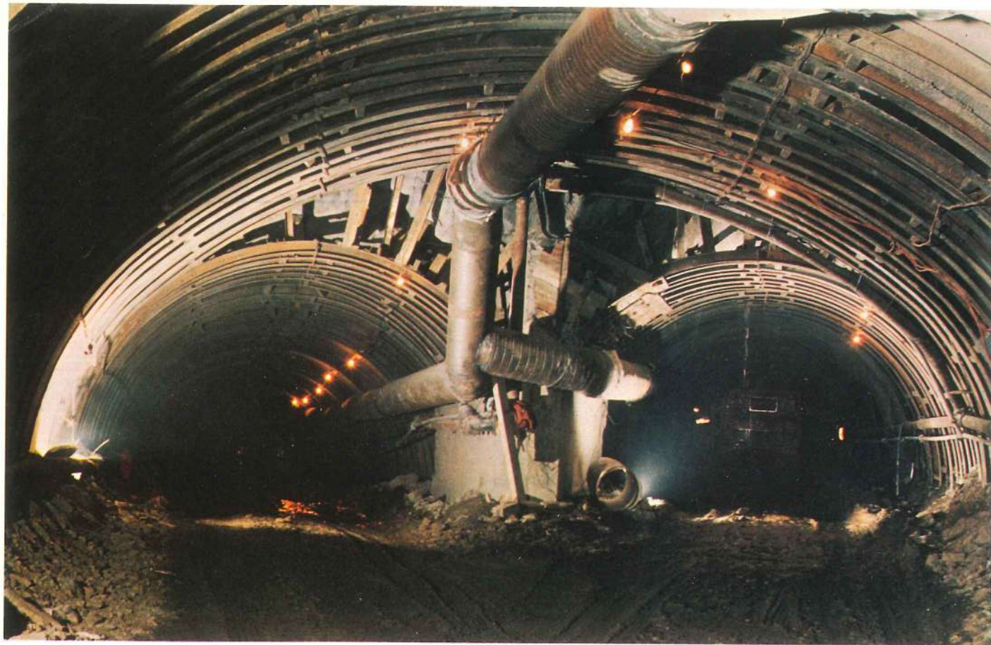
Fasi successive dello scavo delle gallerie
