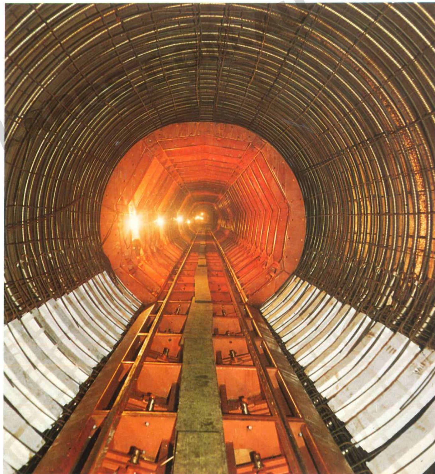
Armatura lenta e di precompressione pronta per il getto
