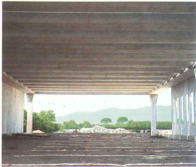
◀ Vedute all'interno dello stabilimento in fase di finitura Inside view of the factory during the finishing stage ▶
