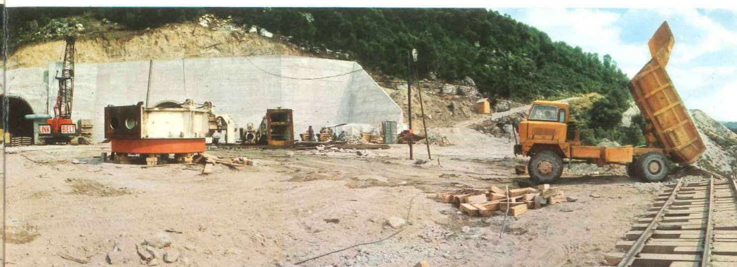
Veduta d'insieme del Cantiere Overall view of the site
