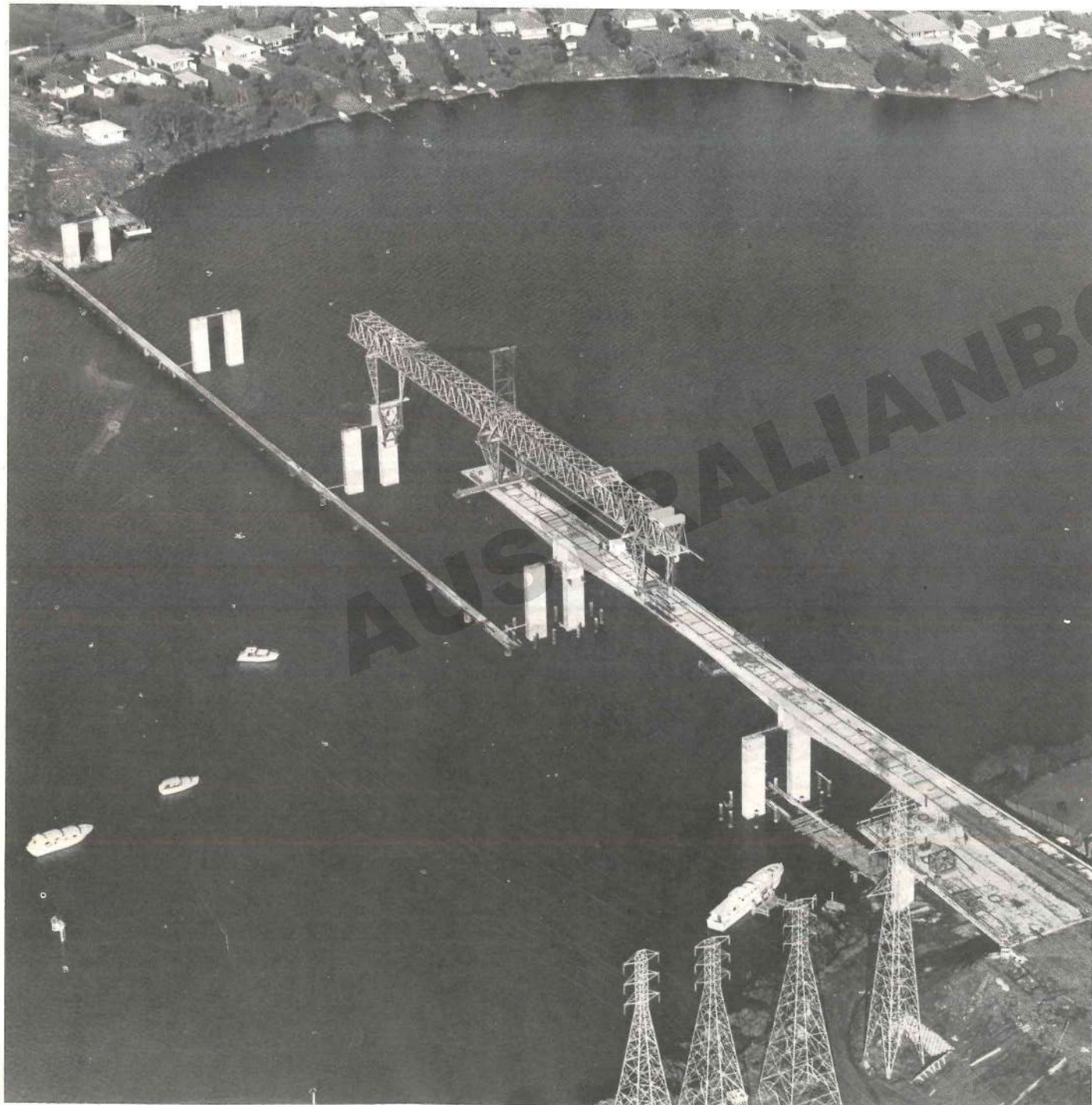
La trave di varo in posizione di lavoro sta disponendo l'ultimo concio di chiusura di una campata Launching-girder in operation positioning the last unit to close a span
