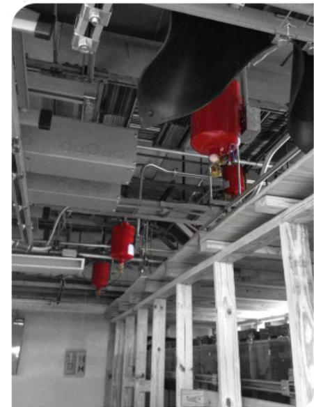
El polvo químico seco es un compuesto formulado por varios tipos de sales & fosfatos, mientras que el FM-200 (HCF-227ea) es un gas licuado comprimido inoloro e incoloro que no deja residuos y tampoco conduce la electricidad, la manera en que funciona es rompiendo uno de los elementos del triangulo de fuego: El calor.
