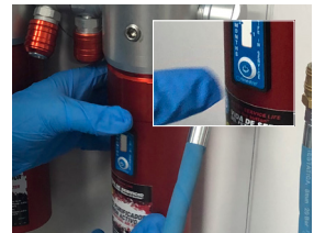
Colocar calendario y pulsar botón de activación
