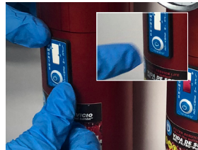
Colocar calendario y pulsar botón de activación
