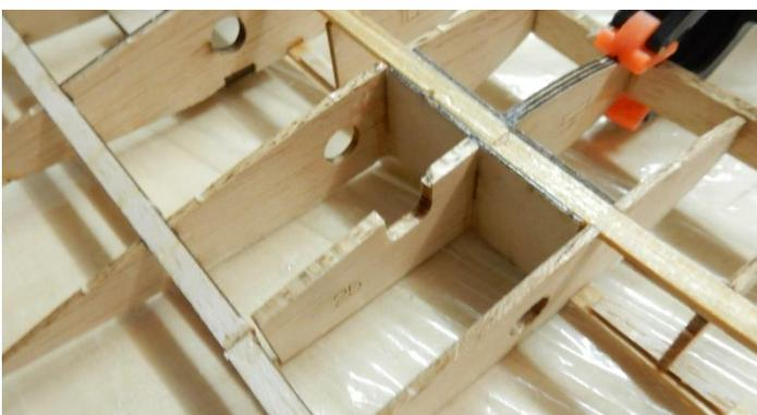
Die beiden Baugruppen in der Mitte des Flügels einbauen. Die Nase schaut nach vorne und oben. Zudem werden die Halbrippen 10 gemäß Bauplan eingeklebt.
