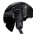
Batería conectada al controlador
