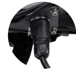
Batteria collegata al controller
