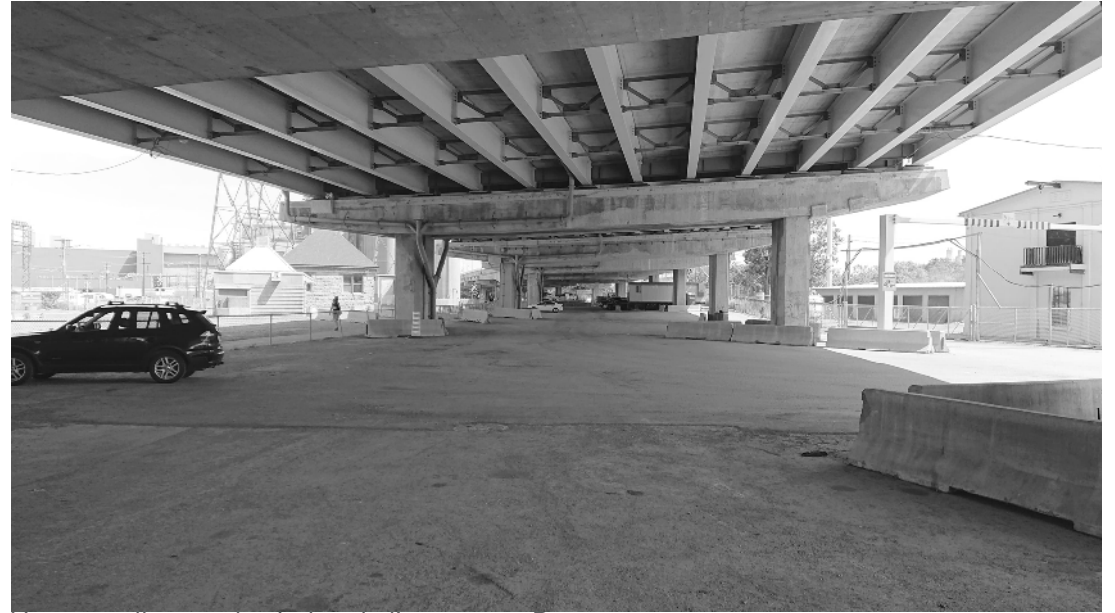
Vue actuelle sous le viaduc de l'autoroute Bonaventure, depuis le carrefour Mill-Riverside.
