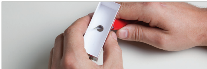
Abb. 38: Bohrung im Fahrzeugaufbau ausbessern
