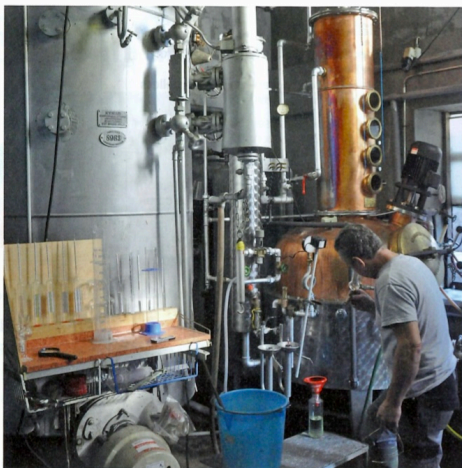
Wenn Dampfkessel (links) und Brennofen in Betrieb sind, entstehen in der Brennerei Schegg Edelbrände.
