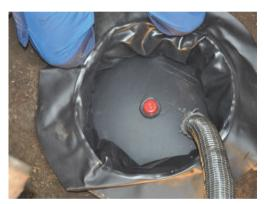
10. Ziehen Sie den zylindrischen Teil des Domhalses nach oben und führen Sie ihn durch den Dom.
