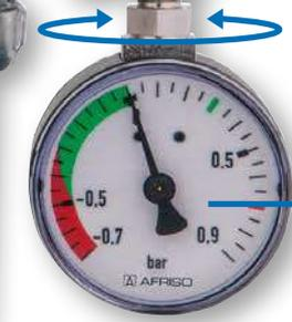
Flexibel drehbare Serviceanzeige für den Anlagenbesitzer. Notwendiger Filterwechsel kann selbst erkannt werden. Ist der Filtereinsatz verschmutzt, steigt das Vakuum an und der Fachhandwerker kann informiert werden.
