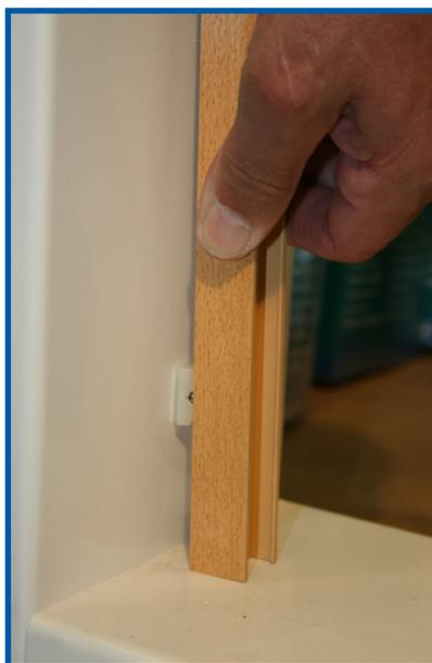
5. Nun sollte es möglich sein die Schiene mit den Fingern von den Clipsen abziehen. Im nächsten Schritt folgt die gegenüberliegende Schiene und am Ende die obere Gleitschiene.
