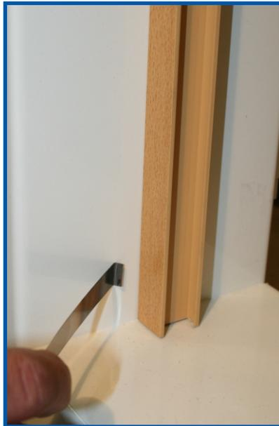
2. Als Werkzeug eignet sich sehr gut ein abgewinkeltes Edelstahlblech von 1 mm Stärke. Alternativ kann ein breiter Holz- oder Kunststoffkeil verwendet werden.
