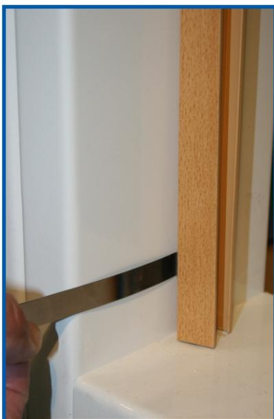
4. Klappen Sie den Blechstreifen zur Seite und hebeln Sie so die Schiene vom Clip, evtl. muss eine Zange zu Hilfe genommen werden.
