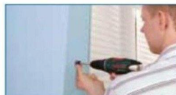
Fixatie van de clips (in de leveringsomvang inbegrepen)
