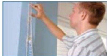
Metten van de deuropening (breedte en hoogte)
