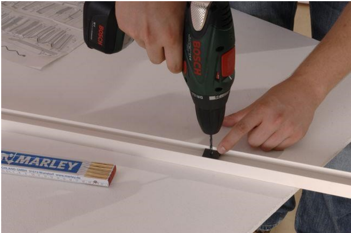
Afbeelding 26 van 37: Boor het gat voor met een boor van 4 mm, verwijder de clip en boor het gat vervolgens uit tot 6 mm.
