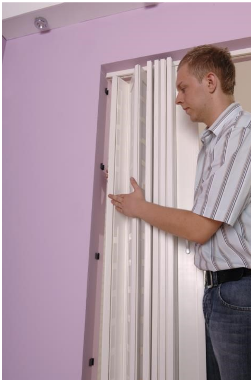
Afbeelding 33 van 37: Druk vervolgens de zijaanslagrail op de clips.
