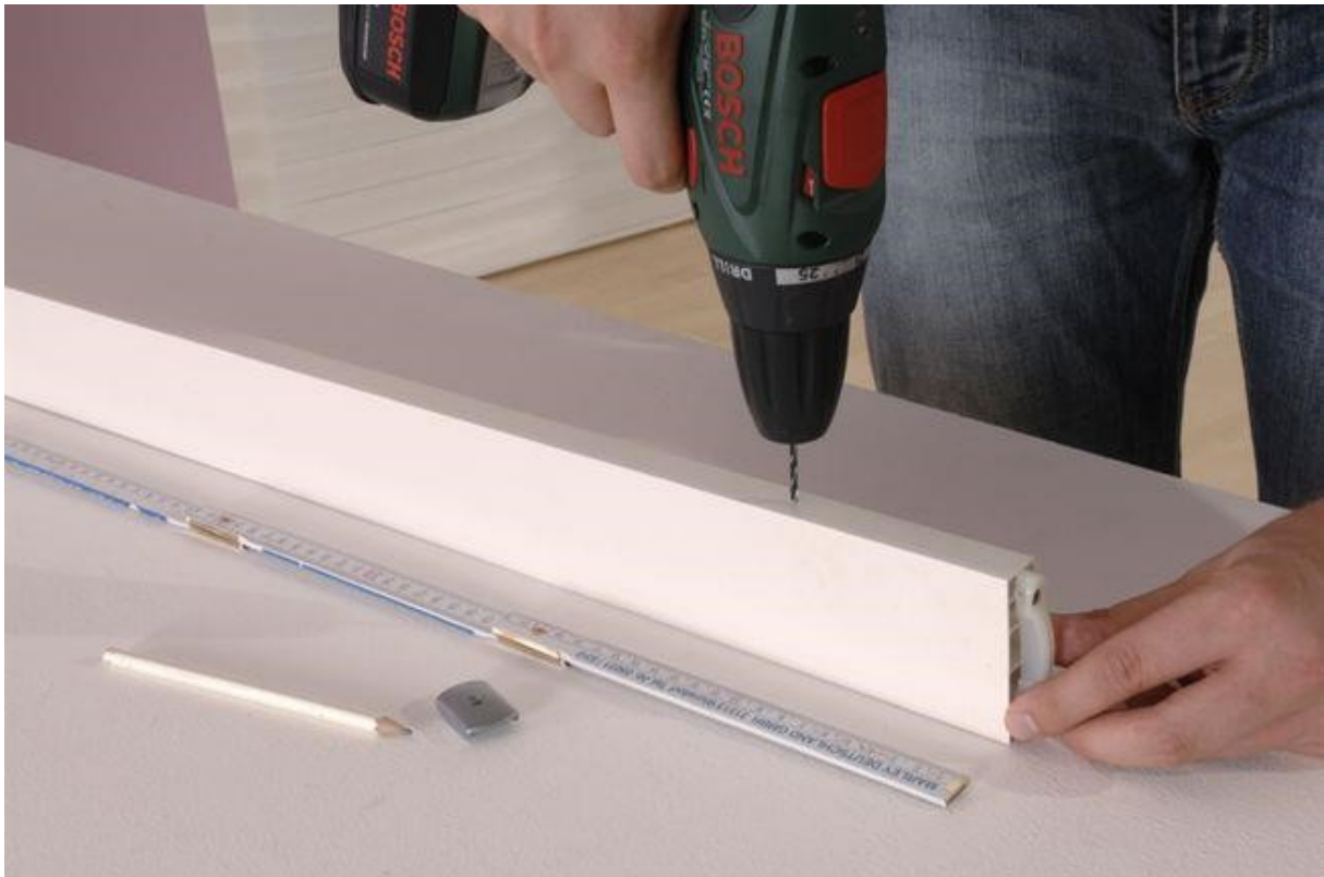
Afbeelding 15 van 37: De gaten worden geboord met een 2,5 mm boor.
