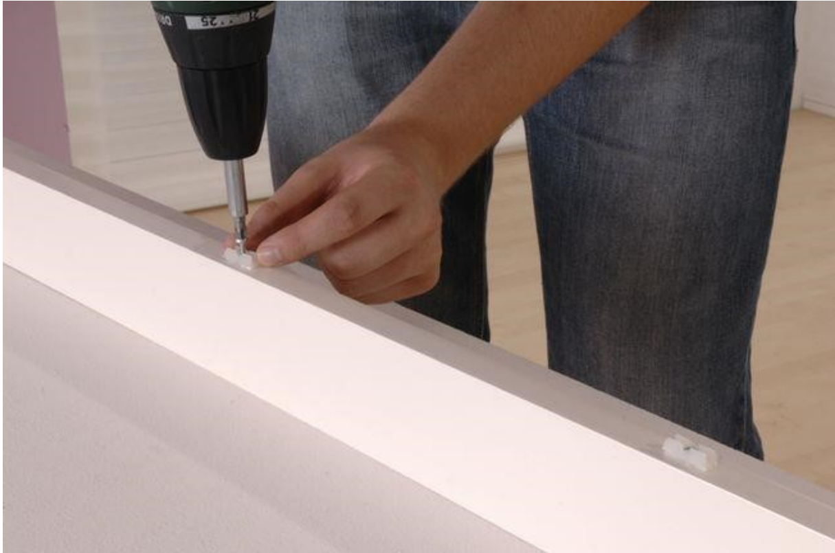
Afbeelding 16 van 37: Schroef vervolgens de witte clips vast ...
