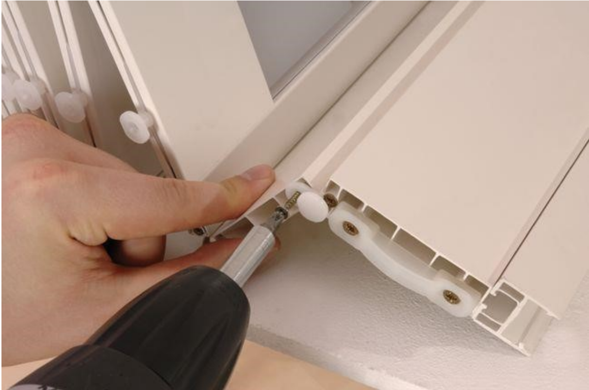
Foto 21 van 37: Een hoekglijder wordt op de halve lamel naast het slotprofiel geschroefd, ...
