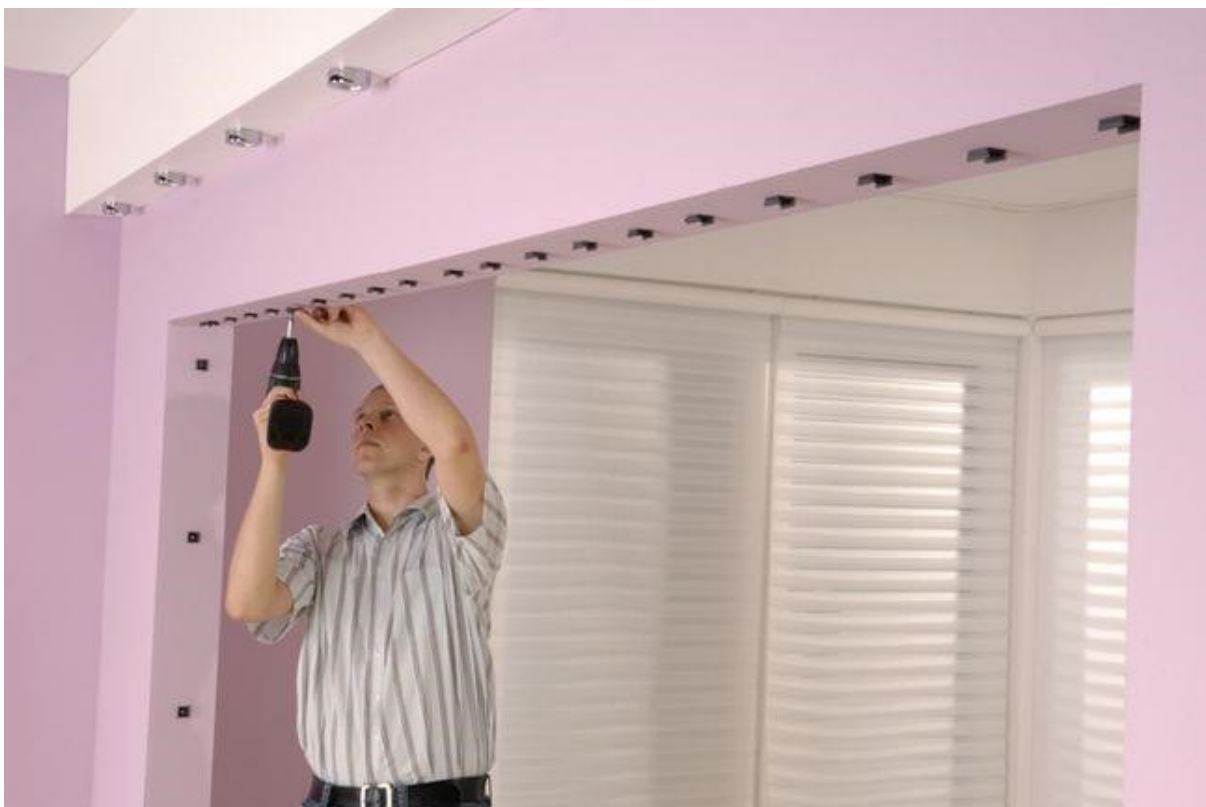
Afbeelding 29 van 37: ... boor de montagegaten en schroef de clips vast.
