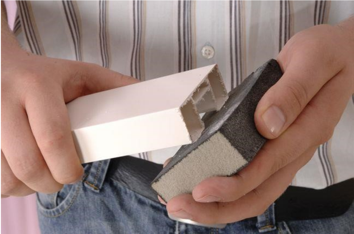
Afbeelding 8 van 37: Na het op lengte snijden, ontbraamt u de snijranden.
