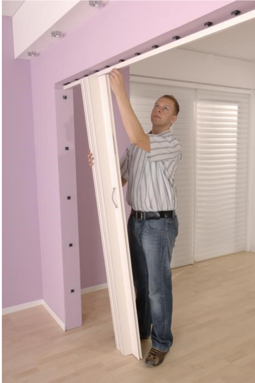
Afbeelding 32 van 37: Het eerste deurblad wordt in de deuropening geplaatst. De schuifrail wordt op de clips gedrukt.
