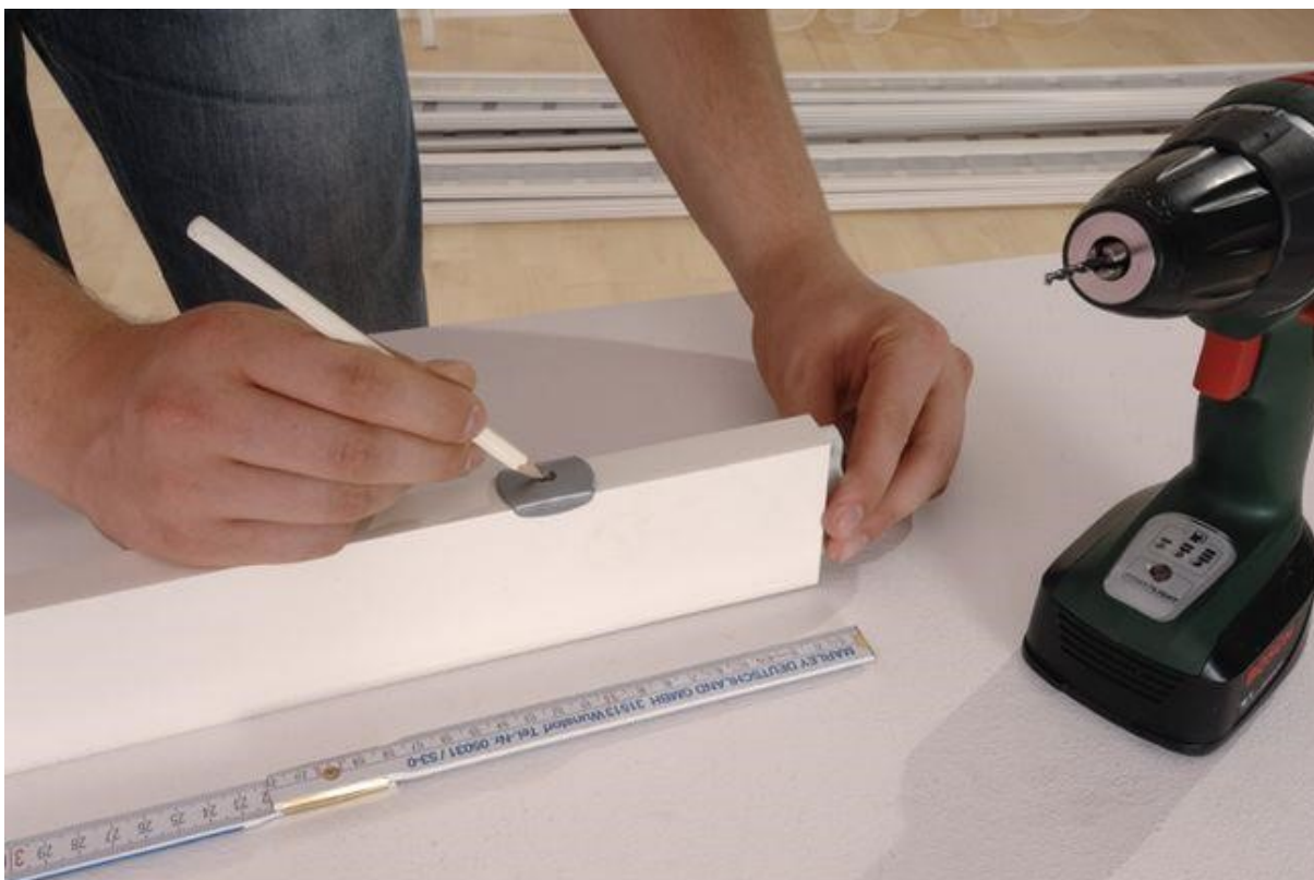
Afbeelding 14 van 37: Op het slotprofiel van de tweede deurleugel wordt nu het andere slotstuk gebruikt als sjabloon voor het markeren van de bevestigingspunten voor het aanslagprofiel.
