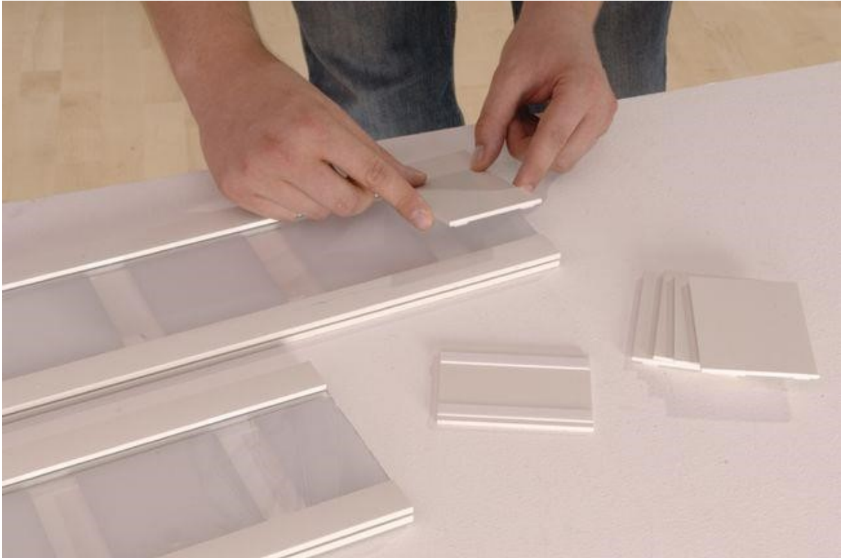
Afbeelding 9 van 37: De eindpanelen worden aan de onderzijde met dubbelzijdig plakband in de verkorte glaslatten gelijmd.
