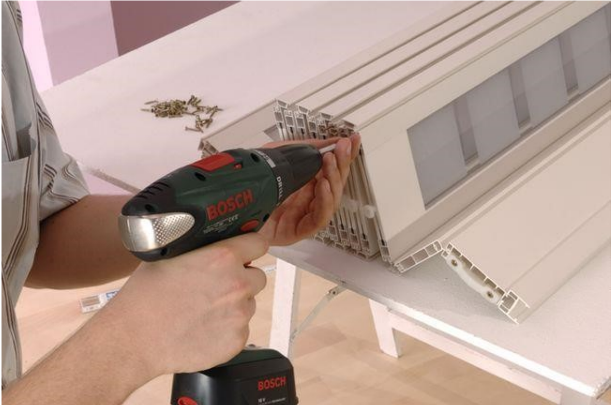
Afbeelding 20 van 37: Bevestig de voegstroken aan de boven- en onderkant tegen wegglijden met schroeven.
