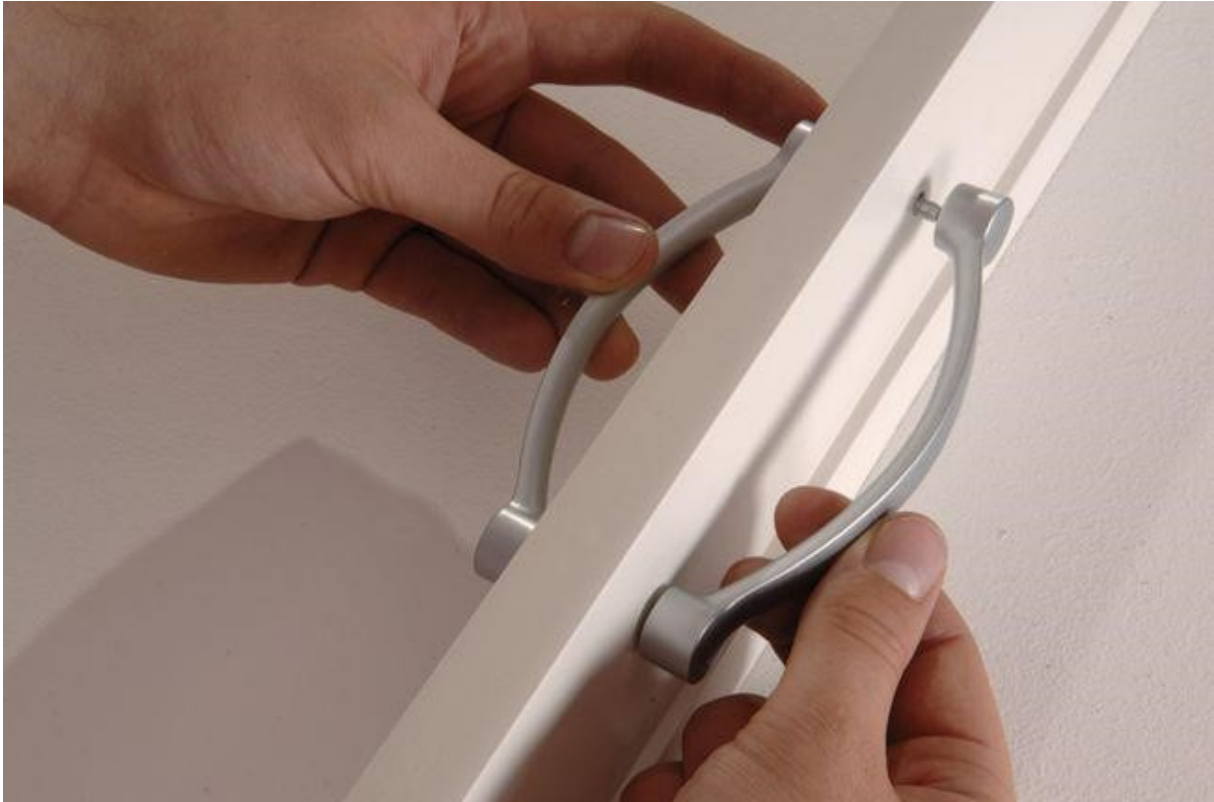
Afbeelding 12 van 37: Steek de gegroefde pinnen in één handgreep, duw ze door de slotlatten, bevestig de tweede handgreep aan de andere kant en druk de handgrepen samen.
