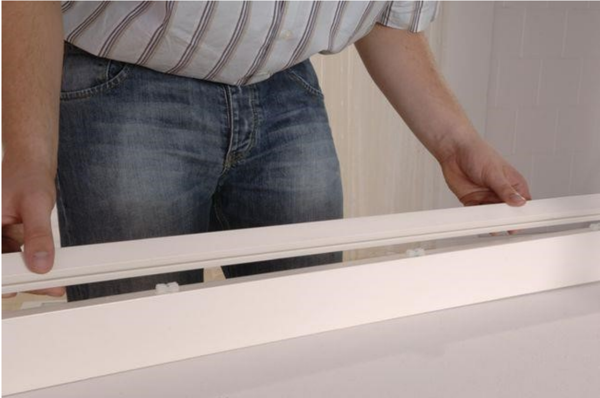
Afbeelding 17 van 37: ... en druk de aanslagrail op het voorbereide slotprofiel.
