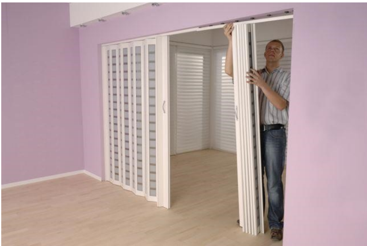
Afbeelding 34 van 37: In de volgende stap wordt de tweede deurvleugel ingevoegd en op de clips gedrukt.
