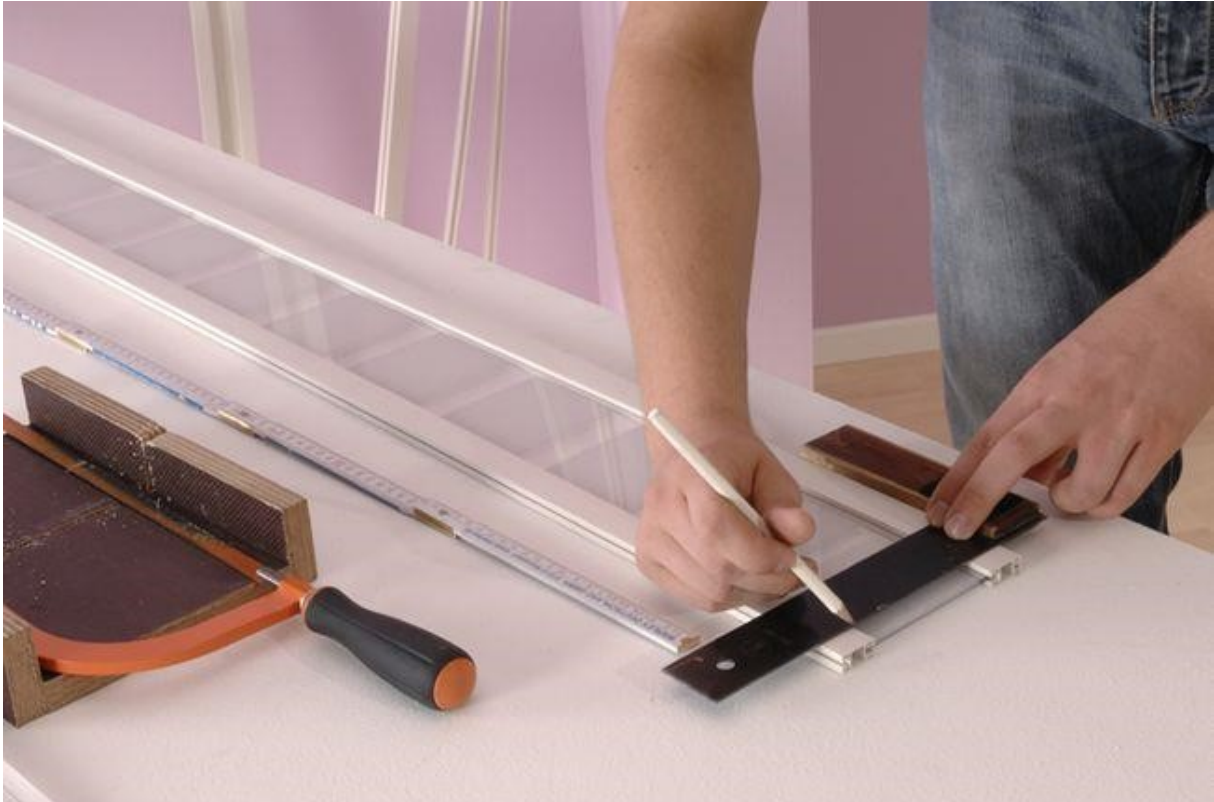
Afbeelding 6 van 37: Markeer nu de bepaalde afmeting op de glazen lamellen ...
