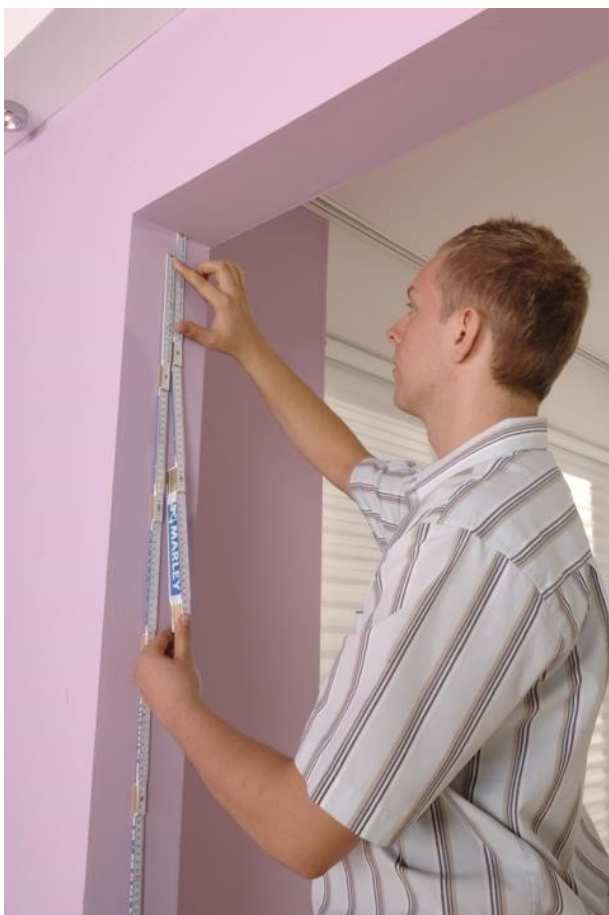
Afbeelding 2 van 37: ... en de hoogte van de deuropening worden gemeten.
