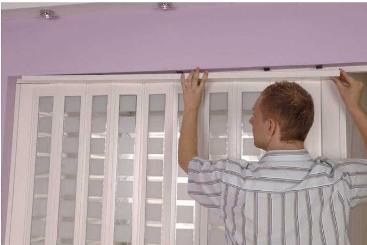
Afbeelding 36 van 37: De hoes wordt eerst aan de ene kant op de eerste clip geschoven en vervolgens op de andere clips gedrukt.
