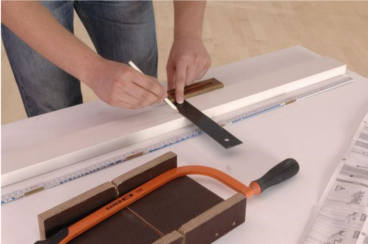
Afbeelding 4 van 37: De berekende afmetingen zijn aangegeven op het slotprofiel, de halve lamellen en de voeg- en aanslagrails.
