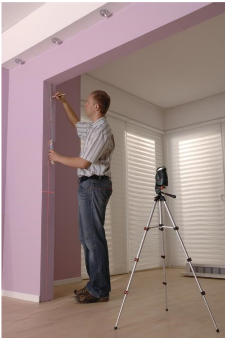
Afbeelding 28 van 37: Markeer de afstanden voor de bevestigingsclips, ...
