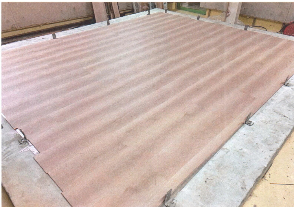
圖6.4 試件施工完成
