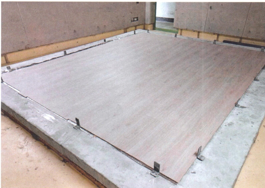
圖6.4 試件施工完成
