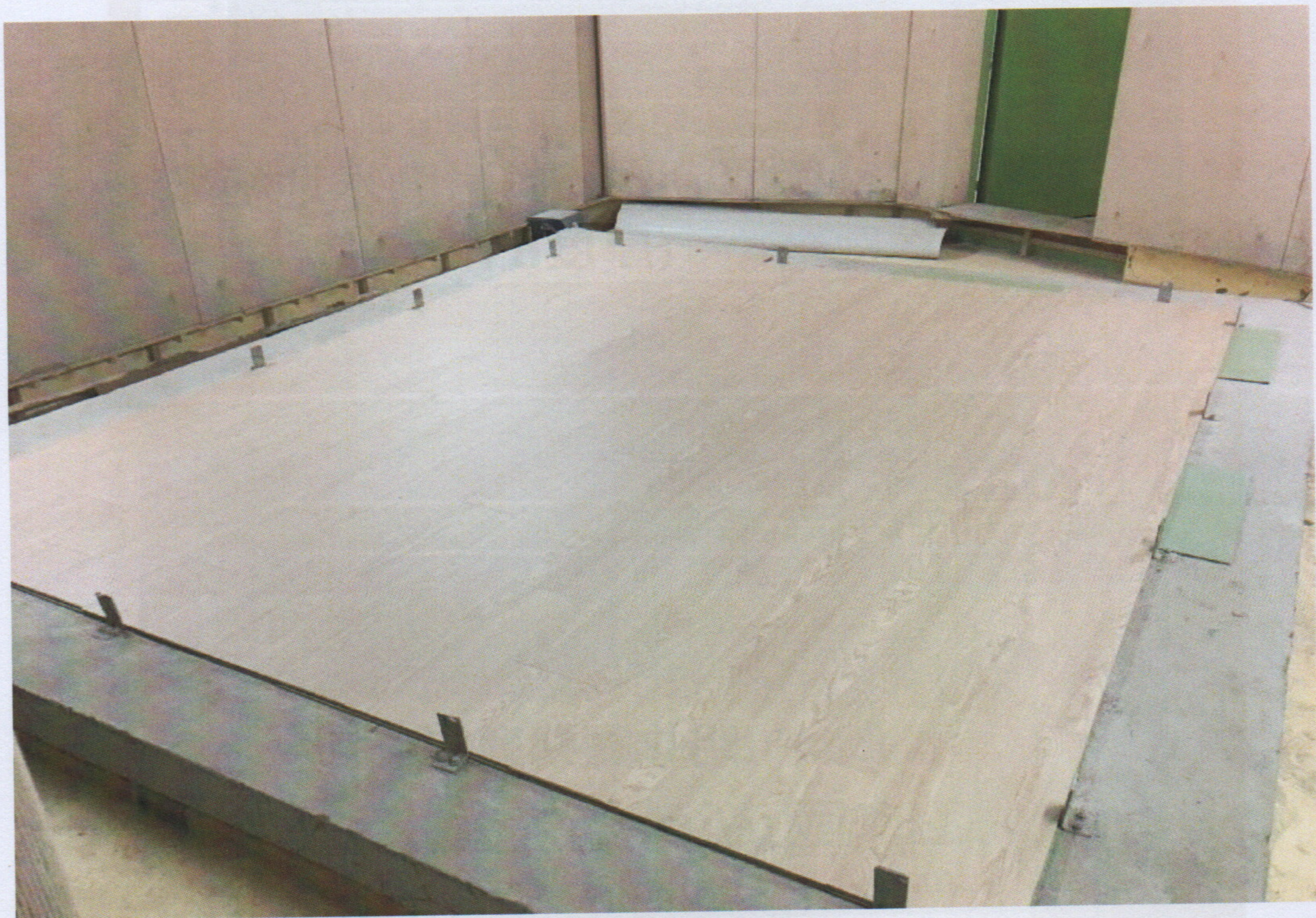
圖6.4 試件施工完成
