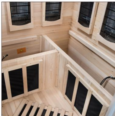
Posizionate le parti inferiori della panca, verificando che si incastrino perfettamente al pavimento e al pannello laterale. I pannelli riscaldanti devono essere orientati verso la porta.
