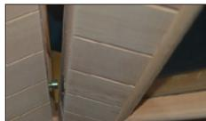
Levante el panel con la muesca macho e insértelo en la muesca hembra del otro panel. Presione hacia abajo para bloquear.
