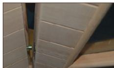
soulever le panneau avec l'encoche mâle puis l'insérer dans l'encoche femelle de l'autre panneau. appuyez vers le bas pour verrouiller.
