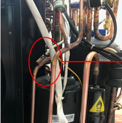
Posição do sensor de temperatura de exaustão: Tubo de cobre de exaustão de gás
