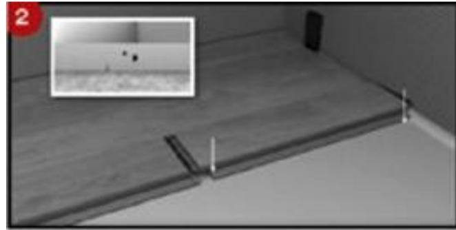
ÉTAPE 3 : IMPORTANT! Utilisez le maillet et la barre de tirage pour frapper sur l'extrémité courte de la planche et ainsi obtenir un ajustement serré.
