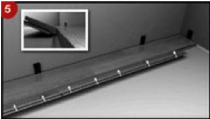
ÉTAPE 6 : Vérifiez que les languettes et les rainures des côtés courts et longs sont bien alignées avant d'abaisser les deux planches sur le sol.
