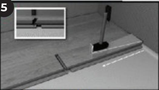
ÉTAPE 5 : En gardant le côté court verrouillé, faites glisser les planches en parallèle avec le sol jusqu'à que la languette du côté long s'insère dans la rainure.
