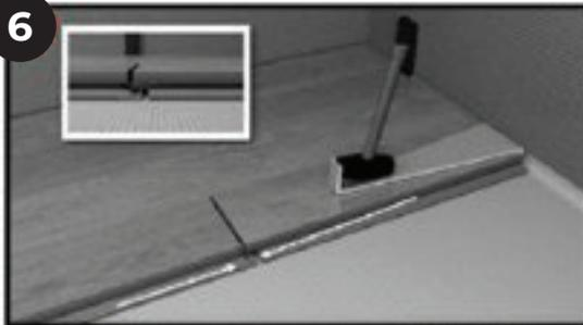
ÉTAPE 6 : Vérifiez que les languettes et les rainures des côtés courts et longs sont bien alignées avant d'abaisser les deux Plancher sur le sol.
