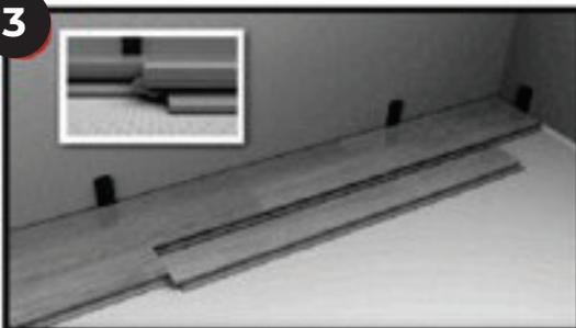
ÉTAPE 3 : Étalez le plancher sur le sol en laissant un espace de 2 à 3 cm entre les Plancher.
