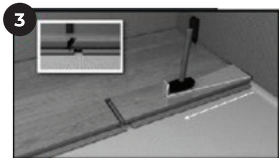
ÉTAPE 3 : **IMPORTANT!** Utilisez le maillet et la barre de tirage pour frapper sur l'extrémité courte du carreau et ainsi obtenir un ajustement serré.
