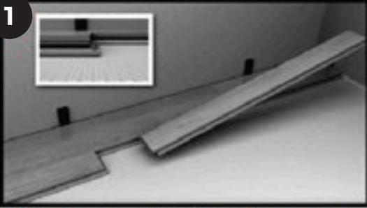
ÉTAPE 1 : Verrouillez en place le côté court du carreau en insérant la languette dans la rainure.
