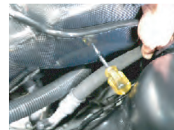
フィルターカバーをビスBで取り付けます。(側面はエアコンホースがあって、ドライバーが入りにくく、固定しにくいので。)
