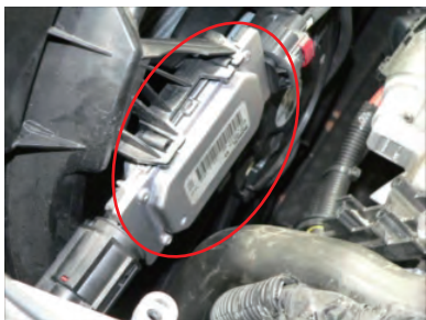
3. ラジエーターの裏にあるユニットを一度外してフリーにします。 ユニットは下側の爪で固定されています。
