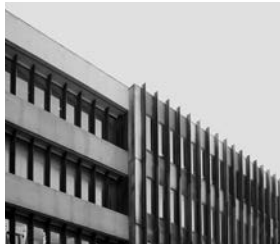
1979 Edifício Banco Espírito Santo Rua José Falcão, 158/176, Porto
