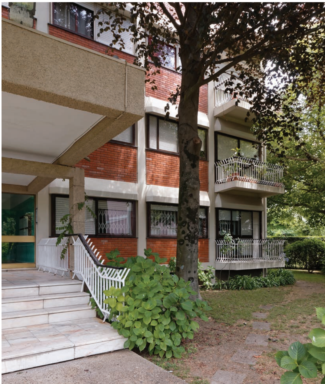
Evidenciação de linhas horizontais Edifício Residencial Rua Correia de Sá, 217-245, Porto © Carlos Albuquerque Castro
