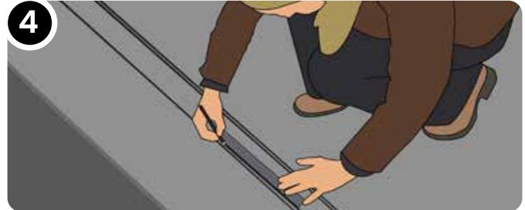
Open de garagedeur en trek een lijn aan de voorzijde van het profiel, over de hele lengte. Verwijder het drempelprofiel. Trek nu binnen de gemaakte markering twee nieuwe lijnen, ieder op ca. 1 cm van de bestaande lijnen. Teken een zigzagpatroon binnen deze 2 lijnen, precies in het midden over de volle lengte.
