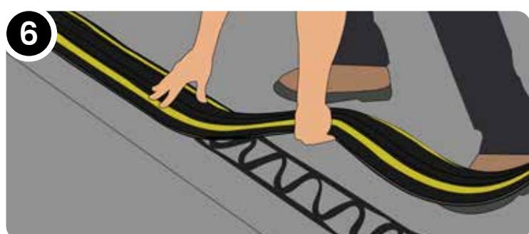
Von einer Seite angefangen, drücken Sie die Bodenabdichtung auf das Abdichtungsmittel und drücken Sie fest nach unten. Fahren Sie mit der Abdichtung fort und vergewissern Sie sich dabei, dass alle Punkte im festen Kontakt stehen. Entfernen Sie das überflüssige Abdichtungsmittel mit einem Tuch. Warten Sie 24 Stunden ab, bevor Sie über die Bodenabdichtung fahren können.
