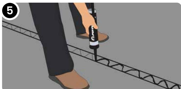
Unter Verwendung des Klebstoff SX Mighty Strength, ein schwarzes Abdichtungsmittel tragen Sie das Abdichtungsmittel auf dem Boden in Ausführung der Bleistiftlinien auf.
