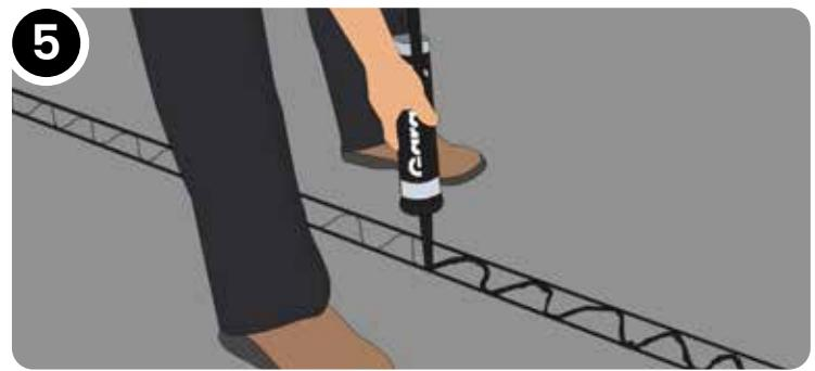
Breng de montagekit aan met behulp van een handkitpistool. Volg daarbij de binnenste lijnen en het zigzagpatroon. De aanbevolen verwerkingstemperatuur ligt tussen +5° C en +25° C.
