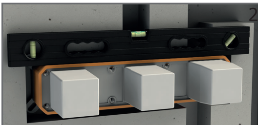
2 NIVELAR LA CAJA (EN EL PROTECTOR PLÁSTICO INCORPORA UN NIVEL DE FORMATO OJO) LEVEL THE BOX (AN EYE LEVEL IS INCORPORATED IN THE PLASTIC PROTECTOR)
