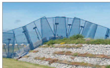
Butte (installation sur Blocs Béton).
