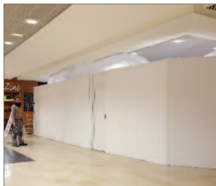
Installation dans la galerie d'un centre commercial Leclerc
