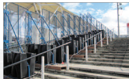
Escaliers (installation sur Blocs Plastique lestés à l'eau).
