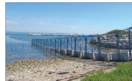
Milieu inondé (installation sur Blocs Béton).
