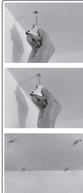
Con il trapano (punta da 8 mm), praticare un foro (profondo 50 mm) in ogni segno. Inserire il TACCHE PER PULEGGE "I" e poi, per non forzare e danneggiare i pulegge, si consiglia di inserire il GANCIO "M" una volta in ogni tassello, quindi i PULEGGE A SOFFITTO "H".
