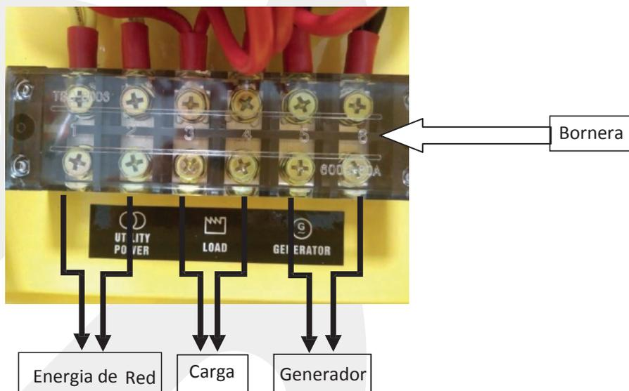
**NOTA:** La potencia de salida total no debe exceder la potencia nominal del ATS; de lo contrario, puede dañar el sistema de transferencia.
