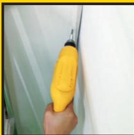
**2** Colocación de tornillos en marcos de ventanas y perforación de agujeros en marcos de madera.
