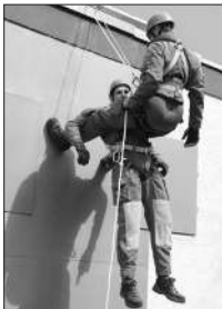
Eksempel: Evakuering som bruker Milan nedstigningsenhet.
