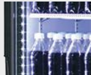
Sistema de iluminación LED
