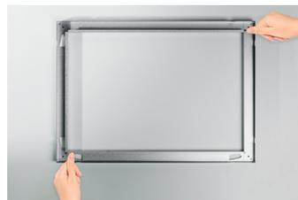
Halten Sie den Grundrahmen an die gewünschte Position, prüfen Sie ob der Grundrahmen in Waage ausgerichtet ist und zeichnen Sie die entsprechenden Löcher an.
