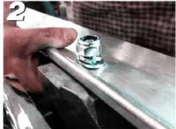
2 Coloque arandelas, tornillos de bloqueo y pernos
