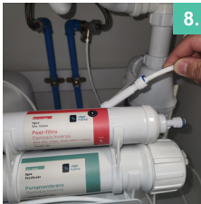
8. Conectar válvula ¼ a tubería de desagüe.
