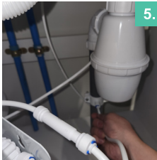
5. Conectar collarín acoplable a la tubería de desagüe.
