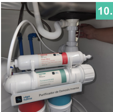
10. Conectar tubería desde el punto de salida de agua purificada hasta llave dispensadora.
