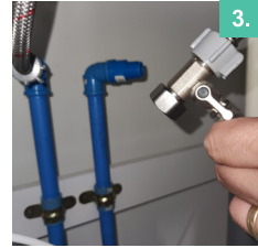
3. Desconectar flexible y conectar a válvula de corte de ¼ (incluí en kit).
