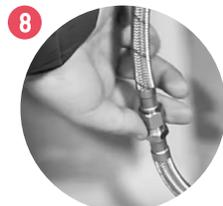
Conecte el flexible original a la manguera de salida.
