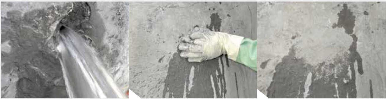
Een lekkagepunt wordt snel en permanent afgedicht met Köster Kelderdicht 2.
