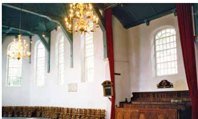
Het metselwerk van dit gebouw is hersteld met KÖSTER Saneermortel wit.
