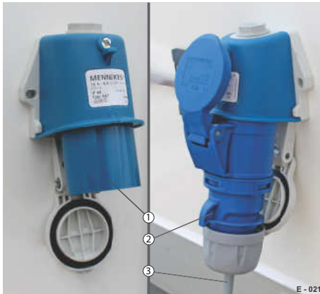
Abb. 23 Netzanschluss, extern
