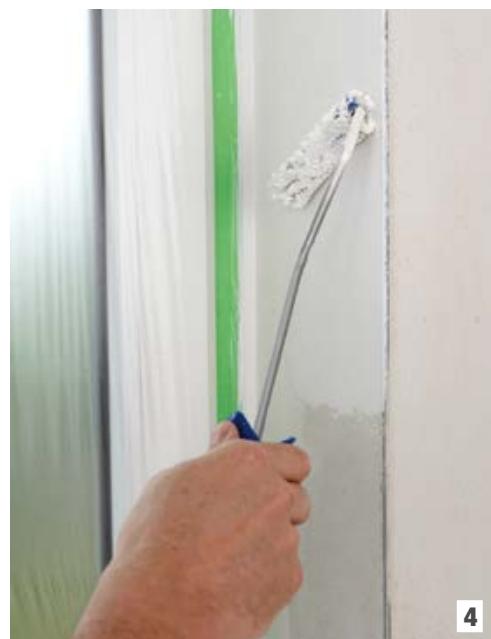
Durch die klebfrei Zone kommt die Farbe nicht mit Klebstoff in Berührung.
