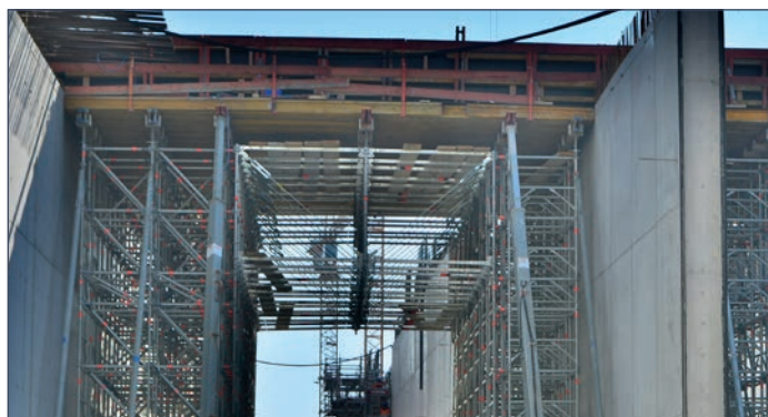
▶ Überbrückung / Durchfahrtsöffnung im Traggerüst mit dem Allround Fachwerkträger.
