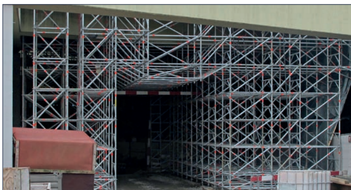
▶ Überbrückung / Durchfahrtsöffnung im Traggerüst mit AllroundGerüst-Standardmaterial.
