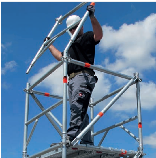
Sichere stehende Montage mit integriertem vorlaufendem Seitenschutz
