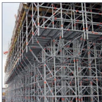
▶ Anbau von Konsolbelagflächen am Rand.
