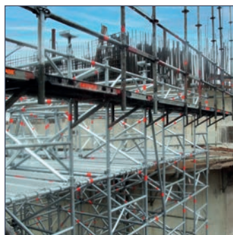
▶ Seitenschutz am Deckenrand.
