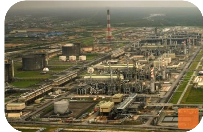
Installations gazières dans l'île de Bony
