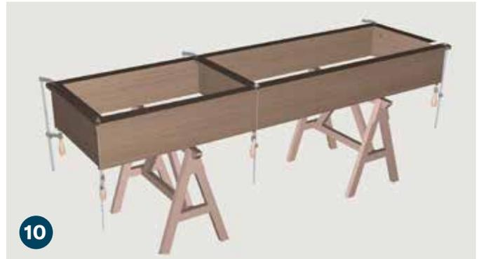
10 Coloque la estantería sobre caballetes, un banco de trabajo o una mesa. Coloque (6) abrazaderas de madera en las esquinas y en el centro de la librería para asegurar el marco frontal mientras se seca el pegamento.
