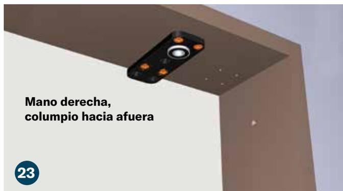
Para una puerta abatible hacia la derecha, fije la bisagra superior de la jamba (G) a la parte superior de la jamba usando (4) tornillos Phillips de cabeza plana y punta afilada de 1" (K), alineando la bisagra como se muestra. Asegúrese de que solo use cuatro tornillos. No perforo los dos orificios más cercanos al borde de la jamba, ya que esto puede dividir el borde.
