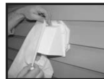
Coloque el LintCatcher sobre la ventila
