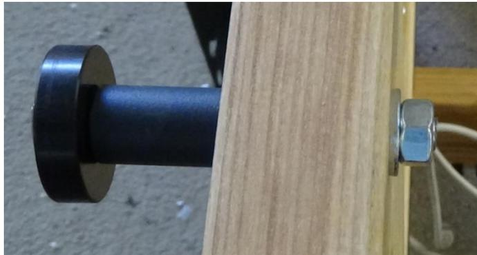
**Figura 79 - Soporte de riel y montaje con perno**
