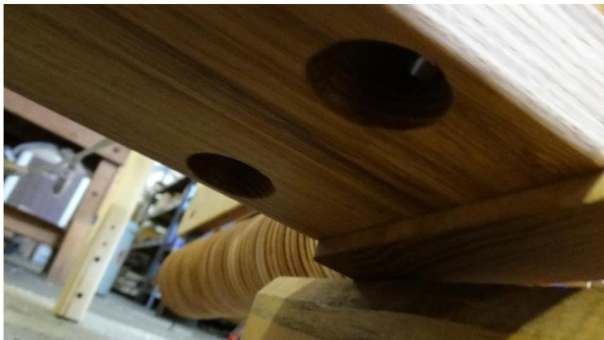
**Figura 18 : primer plano de los orificios de acceso para tuercas**
