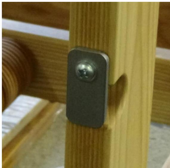
**Figure 60 - Dispositif de retenue de faisceau**
