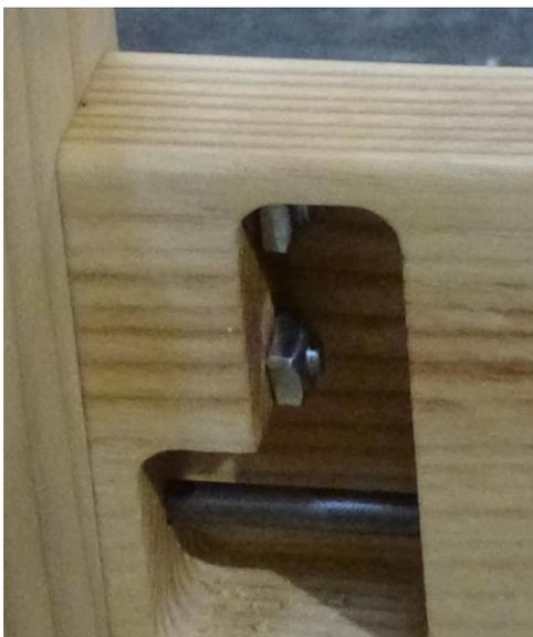
**Figure 15 - Traverse avant fixée au cadre latéral**
